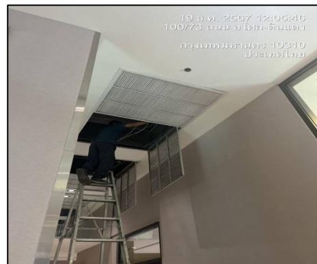
รูปที่ 11 (ต่อ) ทำความสะอาดเครื่องปรับอากาศ
