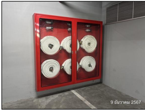
รูปที่ 70 (ต่อ) ตู้เก็บสายฉีดน้ำดับเพลิงพร้อมอุปกรณ์การใช้
