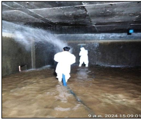
รูปที่ 45 (ต่อ) ล้างถังเก็บน้ำของโครงการ
