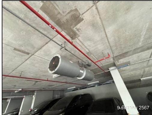
รูปที่ 9 ระบบระบายอากาศแบบพัดลมเจ็ต (Jet Fan)
