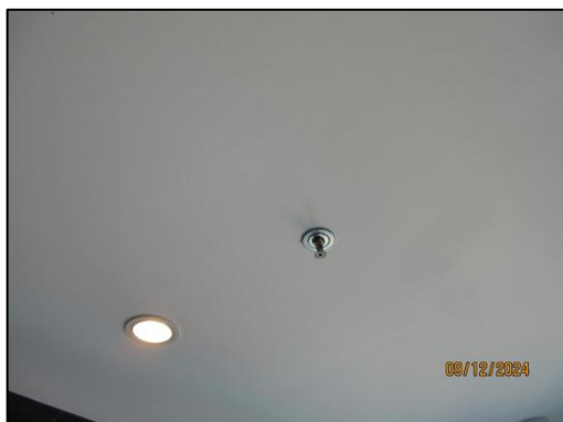
รูปที่ 71 หัวกระจายน้ำดับเพลิงอัตโนมัติ
