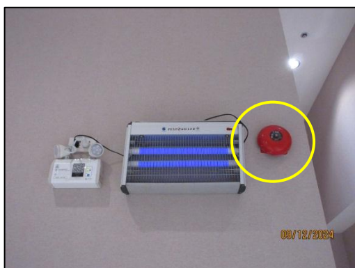
รูปที่ 73 อุปกรณ์แจ้งสัญญาณเตือนด้วยเสียงกระดิ่ง
