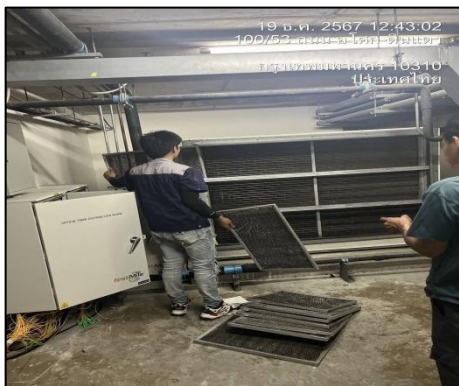
รูปที่ 11 (ต่อ) ทำความสะอาดเครื่องปรับอากาศ
