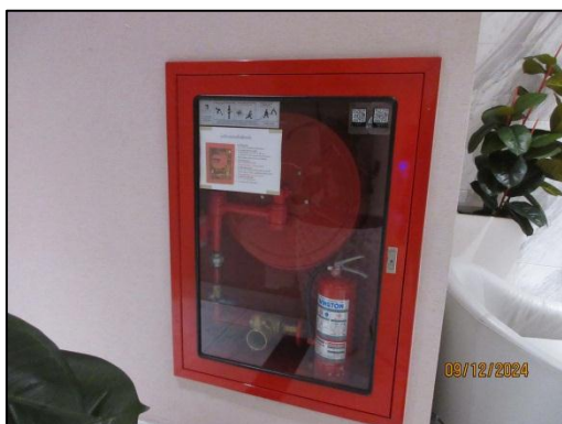
รูปที่ 69 หัวรับและจ่ายน้ำดับเพลิง
