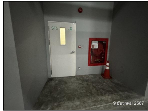
รูปที่ 70 (ต่อ) ตู้เก็บสายฉีดน้ำดับเพลิงพร้อมอุปกรณ์การใช้
