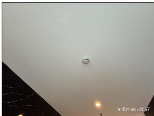
รูปที่ 72 เครื่องตรวจจับควัน
