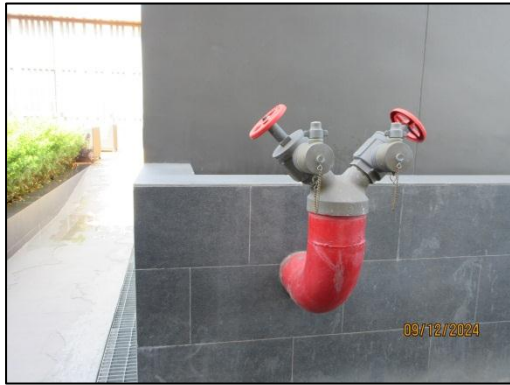
รูปที่ 69 หัวรับและจ่ายน้ำดับเพลิง
