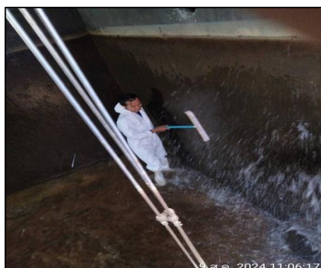
รูปที่ 45 ล้างถังเก็บน้ำของโครงการ
