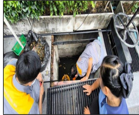
รูปที่ 54 ขุดลอกตะกอนที่ระบายน้ำ
