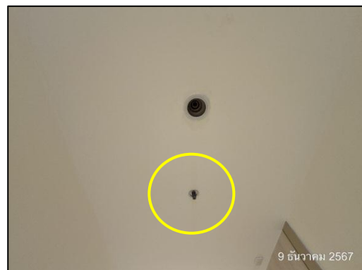
รูปที่ 71 หัวกระจายน้ำดับเพลิงอัตโนมัติ
