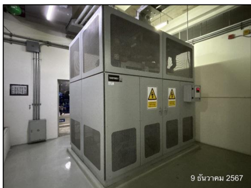
รูปที่ 46 ห้องหม้อแปลงไฟฟ้าของโครงการ
