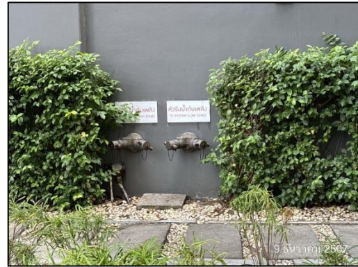
รูปที่ 69 หัวรับและจ่ายน้ำดับเพลิง
