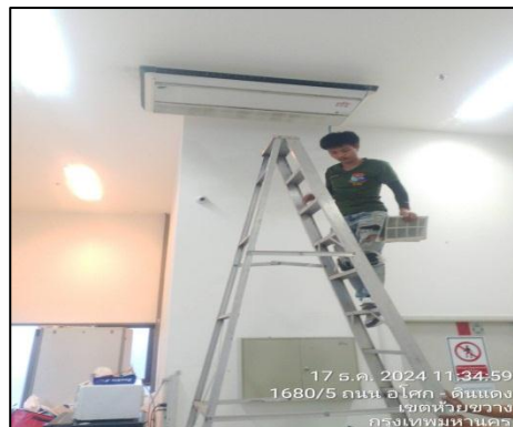
รูปที่ 11 ทำความสะอาดเครื่องปรับอากาศ
