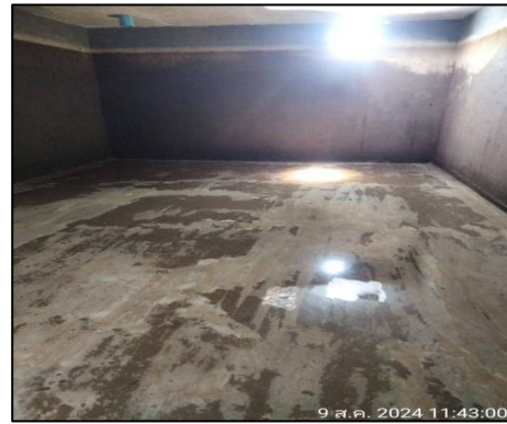
รูปที่ 45 (ต่อ) ล้างถังเก็บน้ำของโครงการ
