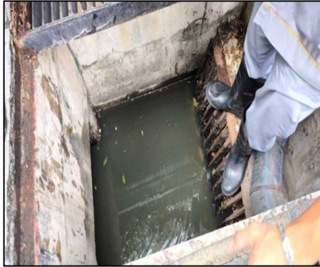
รูปที่ 54 ขุดลอกตะกอนที่ระบายน้ำ
