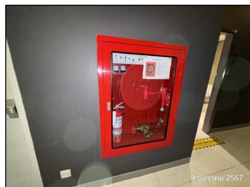
รูปที่ 70 ตู้เก็บสายฉีดน้ำดับเพลิงพร้อมอุปกรณ์การใช้
