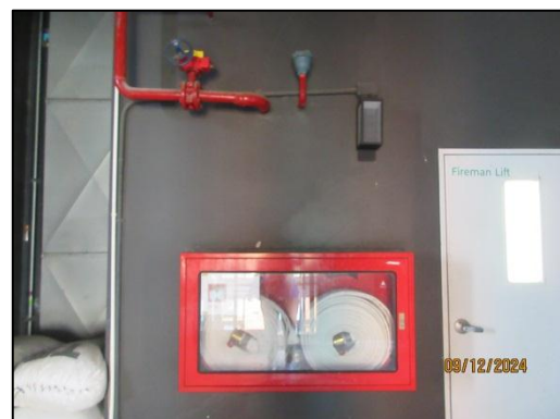
รูปที่ 69 หัวรับและจ่ายน้ำดับเพลิง
