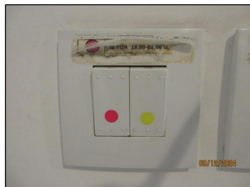
รูปที่ 49 สวิตช์ไฟแยกออกจากกัน ให้สามารถเปิด-ปิดได้เฉพาะจุด
