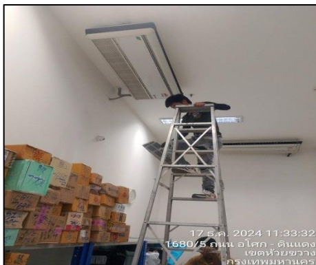
รูปที่ 11 ทำความสะอาดเครื่องปรับอากาศ
